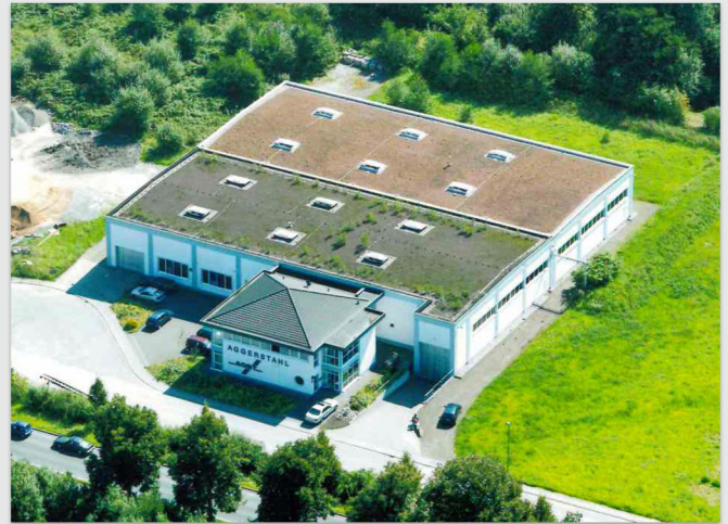
Luftbild des Firmengeländes aus dem Jahr 2008
