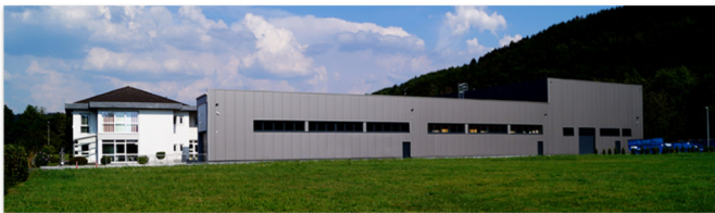
Seitenansicht aus dem Jahr 2019 mit dritter Halle Side view from 2019 with third warehouse
